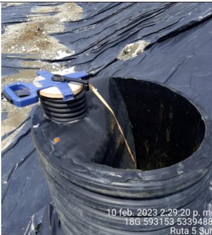
Fotografía N°33: Medición de Niveles de cámaras por Personal Municipal. Tomada: 10 de Febrero del 2023.
