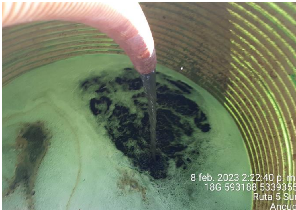
Fotografía N°18: Extracción de Lixiviados a estanque. Tomada: Miércoles 08 de febrero del 2023.
