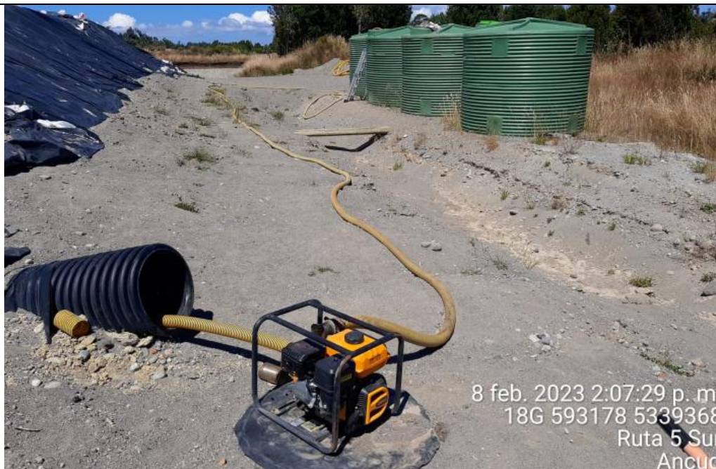
Fotografía N°17: Extracción de Lixiviados desde diagonal D02. Tomada: Miércoles 08 de febrero del 2023.
