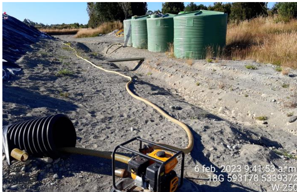
Fotografía N°13: Extracción de Lixiviados desde diagonal D02. Tomada: Lunes 06 de Febrero del 2023.
