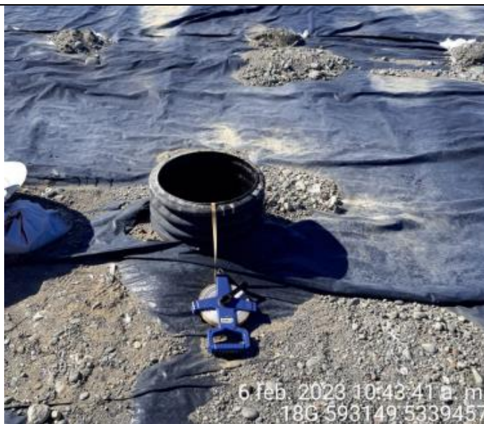
Fotografía N°29: Medición de Niveles de cámaras por Personal Municipal. Tomada: 06 de Febrero del 2023.
