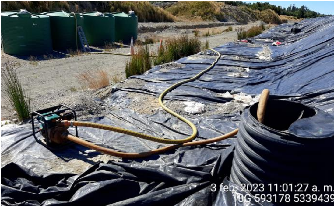
Fotografía N°10: Extracción de Lixiviados desde cámara C12. Tomada: Viernes 03 de Febrero del 2023.
