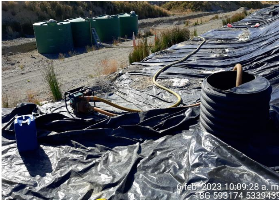
Fotografía N°15: Extracción de Lixiviados desde cámara C12. Tomada: Lunes 06 de Febrero del 2023.
