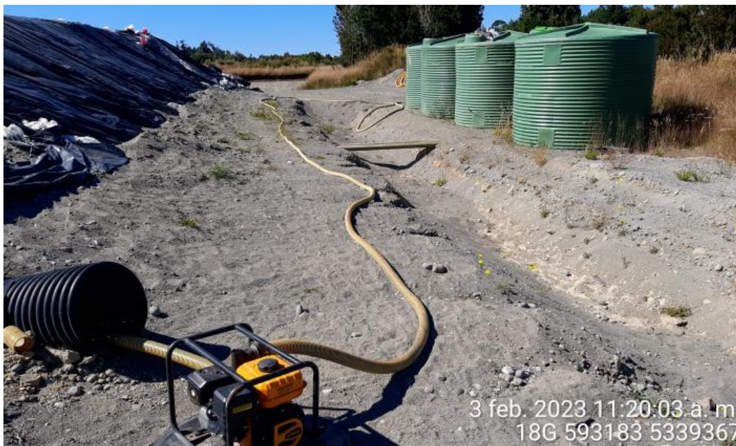
Fotografía N°8: Extracción de Lixiviados desde ducto diagonal D02. Tomada: Viernes 03 de Febrero del 2023.
