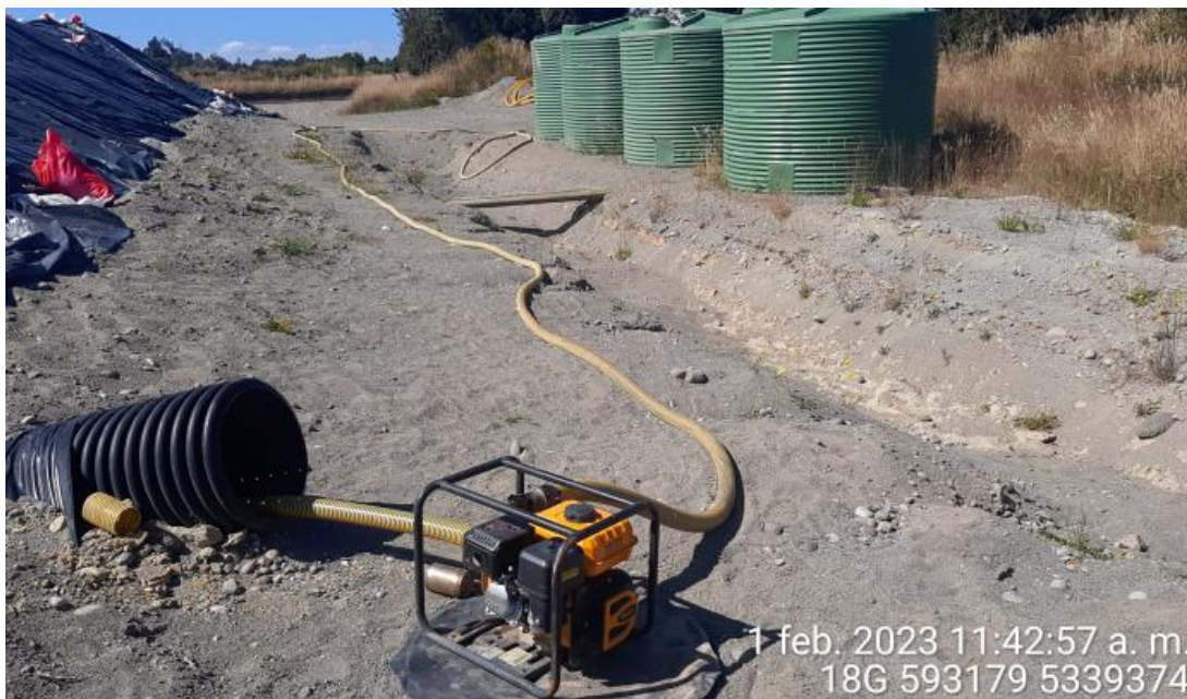
Fotografía N°6: Extracción de Lixiviados desde diagonal D02 por personal municipal. Tomada: Miércoles 01 de Febrero del 2023.
