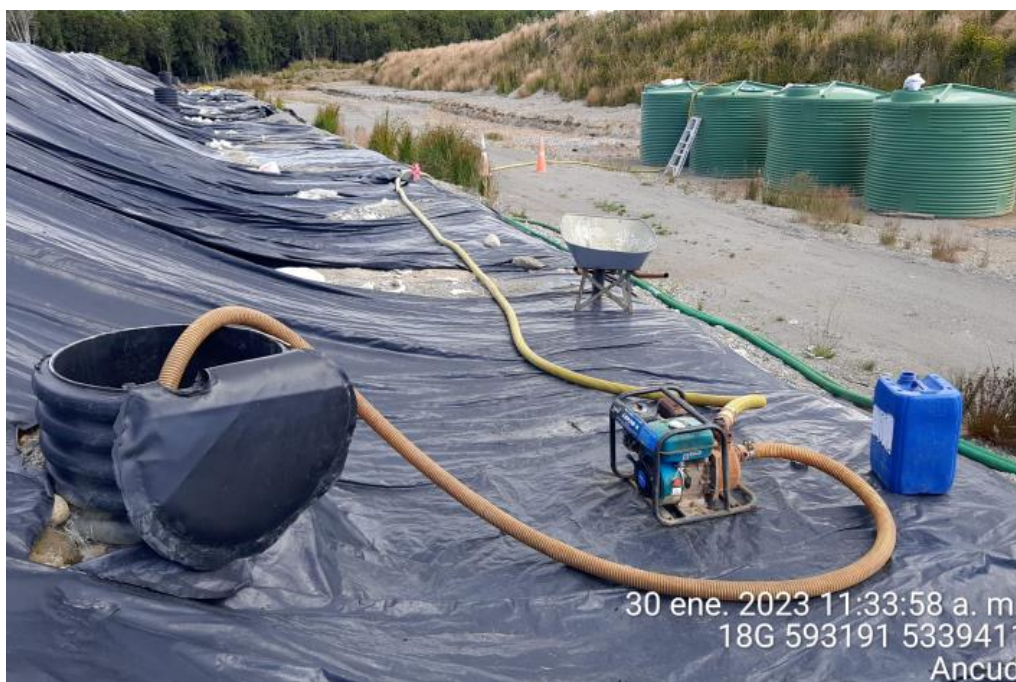
Fotografía N°2: Extracción de Lixiviados desde cámara C13. Tomada: Lunes 30 de Enero del 2023.
