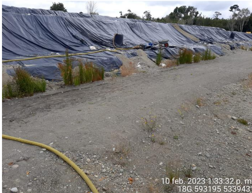
Fotografía N°21: Extracción de Lixiviados desde cámara C12. Tomada: Viernes 10 de Febrero del 2023.
