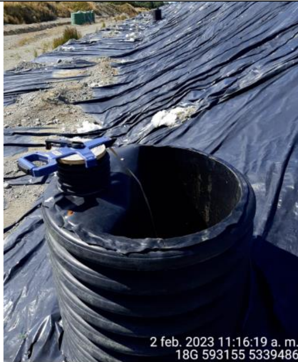
Fotografía N°27: Medición de Niveles de cámaras por Personal Municipal. Tomada: 02 de Febrero del 2023.
