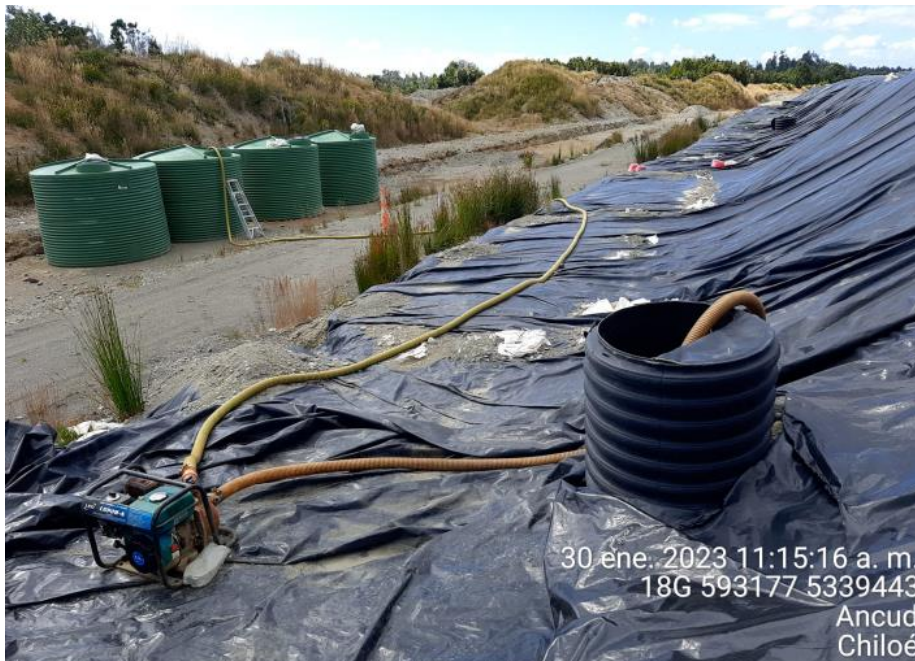
Fotografía N°1: Extracción de Lixiviados desde cámara C12.
