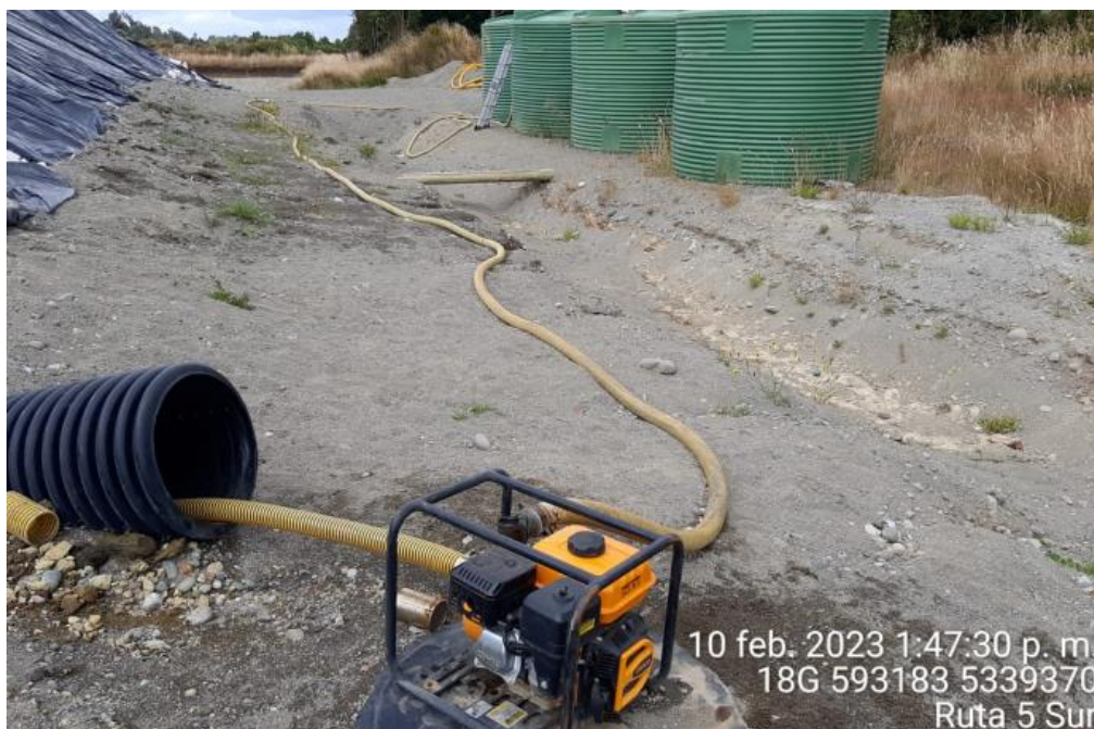
Fotografía N°19: Extracción de Lixiviados dese diagonal D02. Tomada: Viernes 10 de Febrero del 2023.
