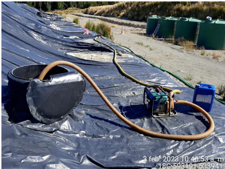
Fotografía N°11: Extracción de Lixiviados desde cámara C13. Tomada: Viernes 03 de Febrero del 2023.
