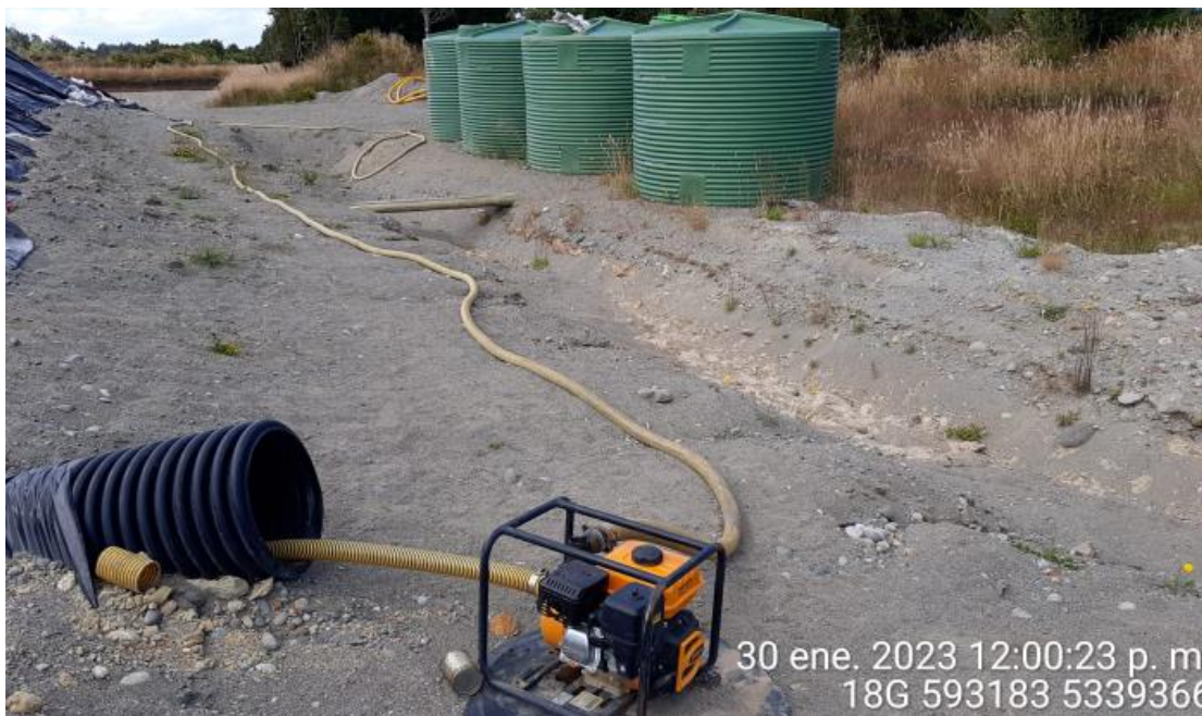
Fotografía N°4: Extracción de Lixiviados desde diagonal D02 por personal municipal. Tomada: Lunes 30 de Enero del 2023.
